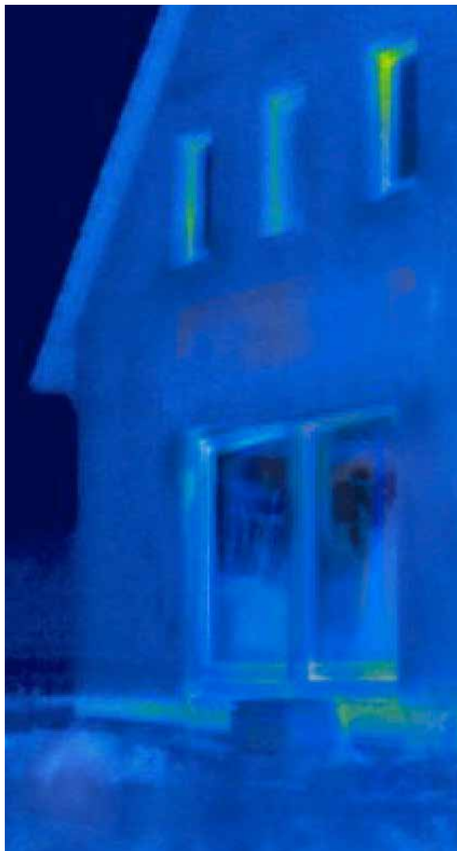
Po renovaci: Použití posuvně-zdvihacích dveří GENE0 redukuje ztelně tepelné ztráty.
